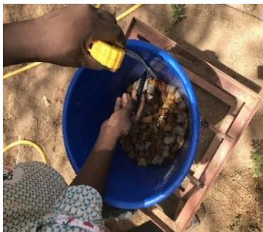
**Figure 10:** Remplissage de la 1<sup>ère</sup> couche de gravier
