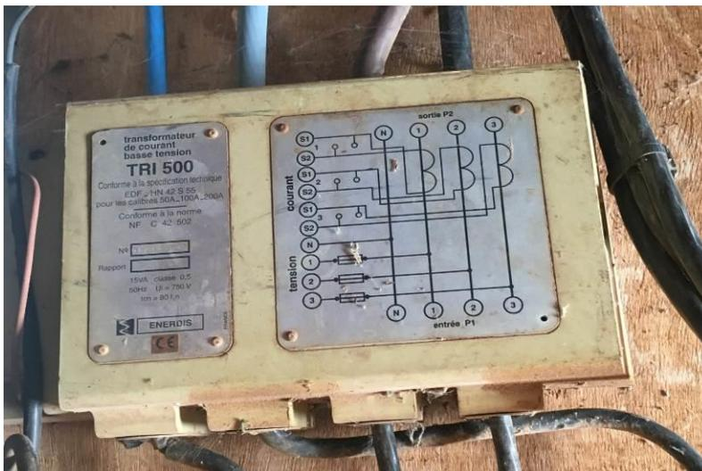
Figure 11: Transformateur d'intensité basse tension
