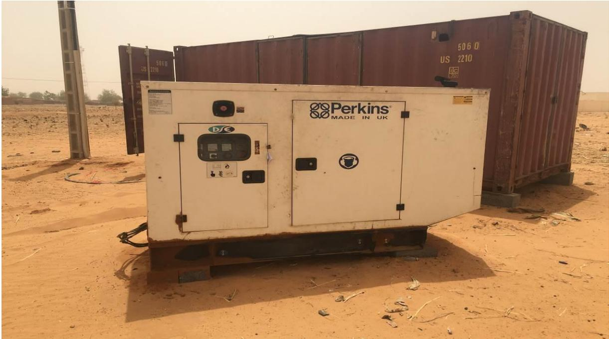
Figure 8: Groupe électrogène Perkins 30kVA modèle 2012
