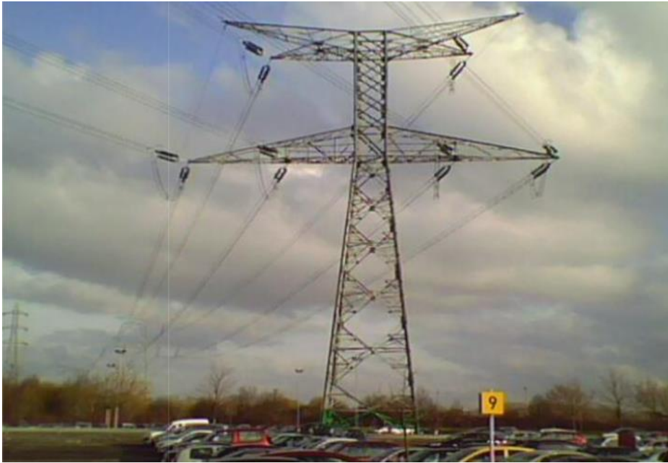
Figure 8: pylône en treillis
