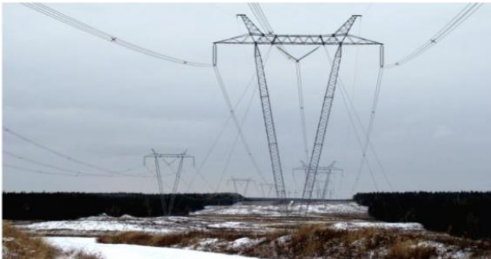
Figure 7: Pylône haubané en V
