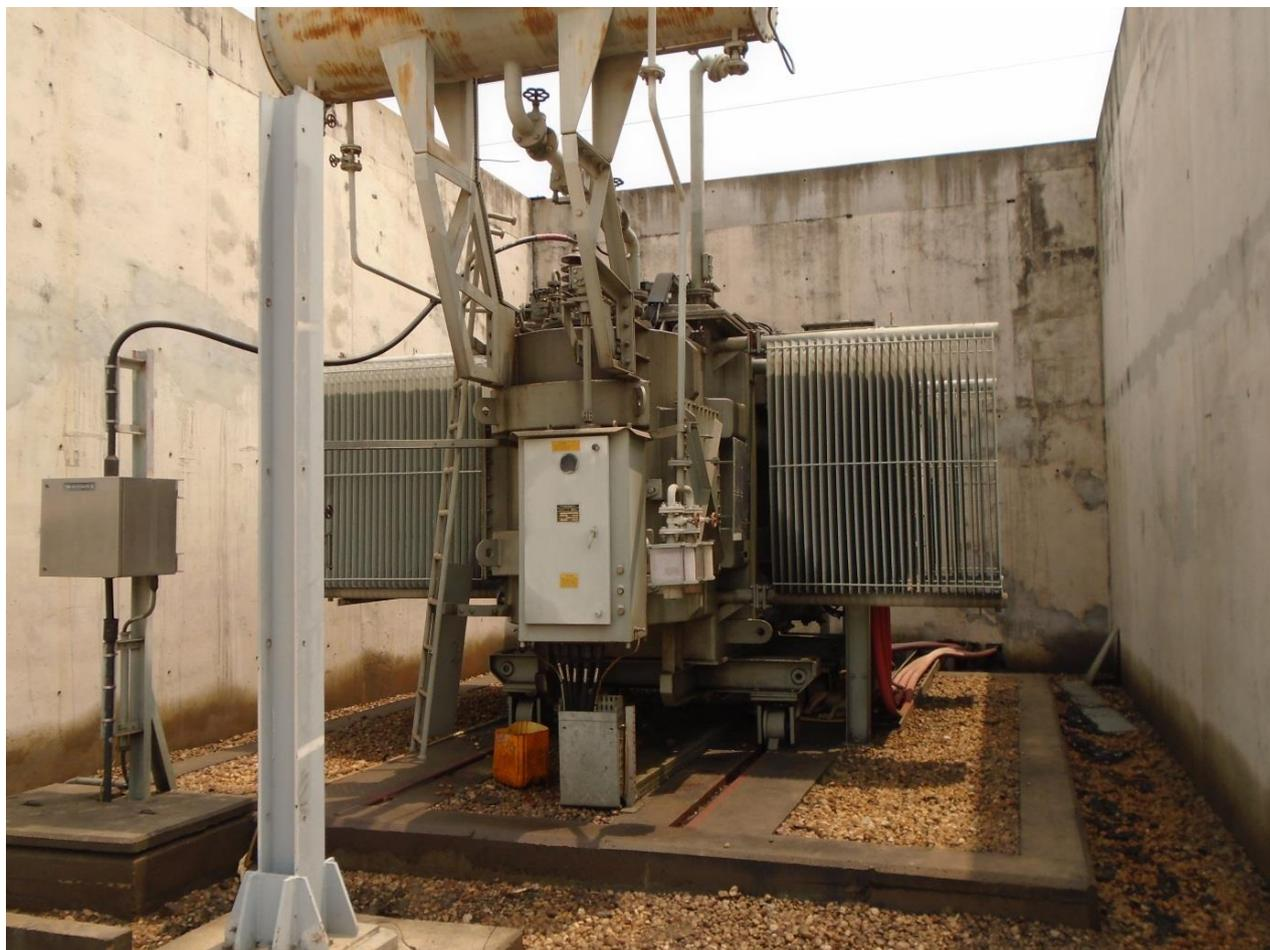
**Figure 34:transformateur 16 MVA du poste source de NGOYO**
