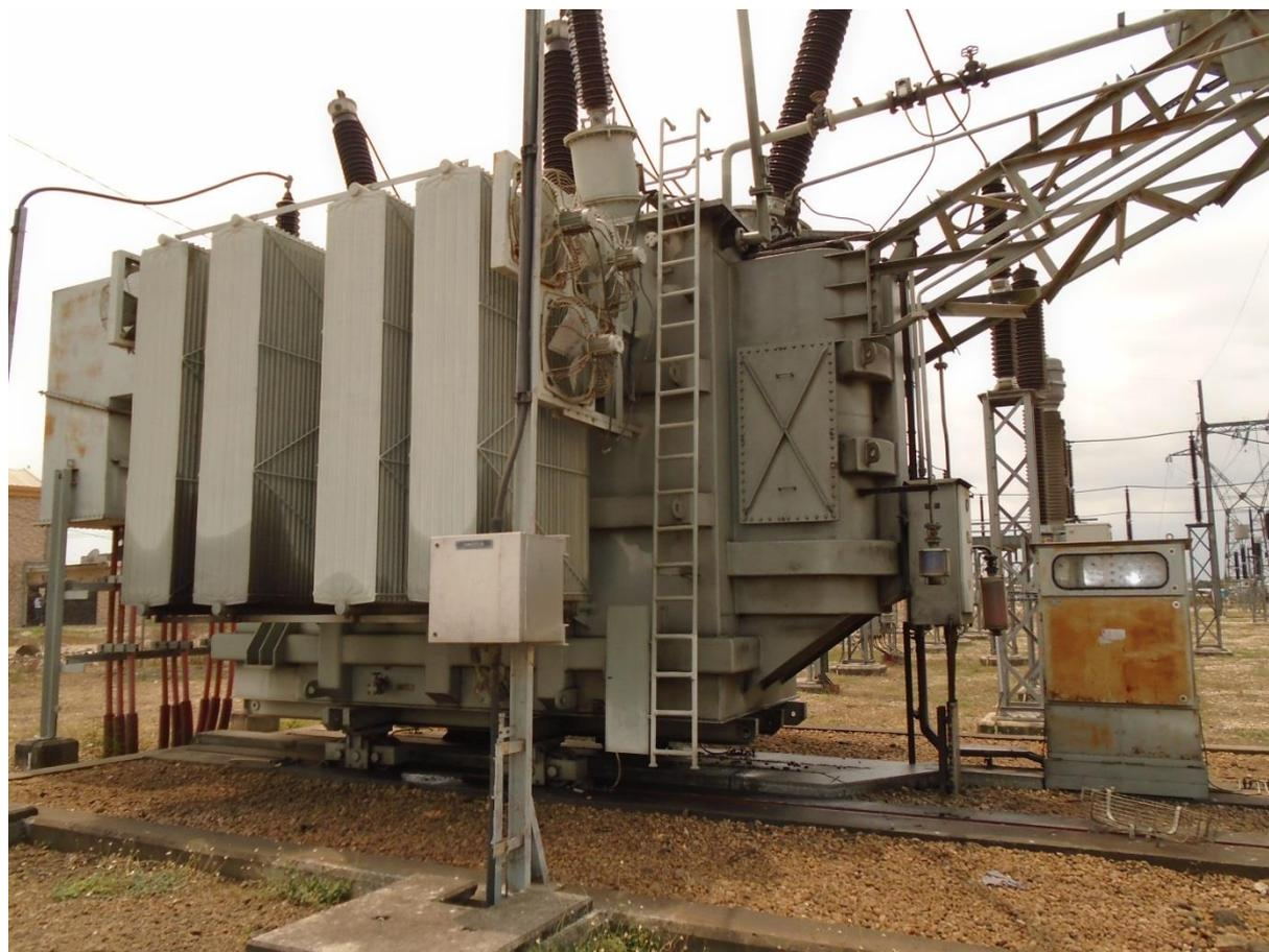
**Figure 35:**transformateur 25MVA du poste source de NGOYO
