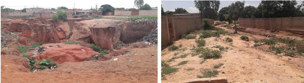
Figure 12: Crevasses, sol rouge et sol hydrophobe difficiles pour l'implantation de supports
