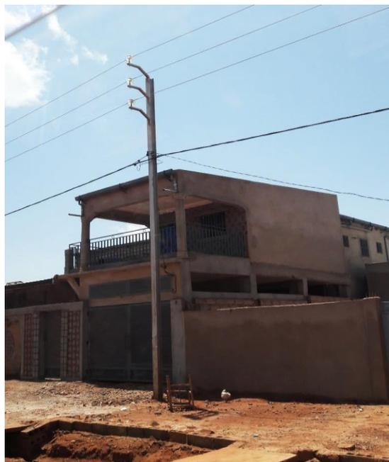
Figure 17: Ligne mixte avec armements type bras inclinés rigides sur une rue réduite.
