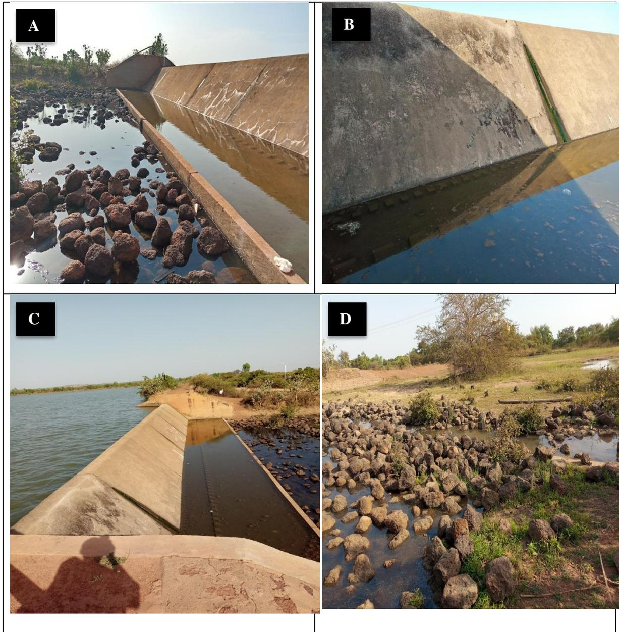
**Figure 4 : L'évacuateur de crue du Barrage de HOUNDE**
