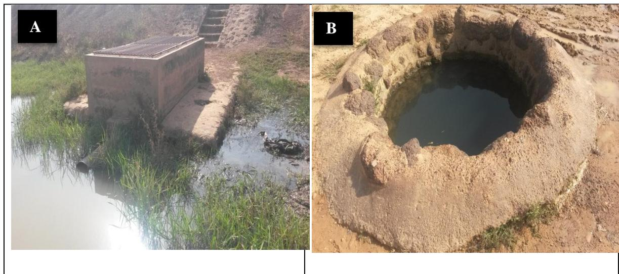
**Figure 5: Ouvrage de prise du Barrage de HOUNDE et un puit**
