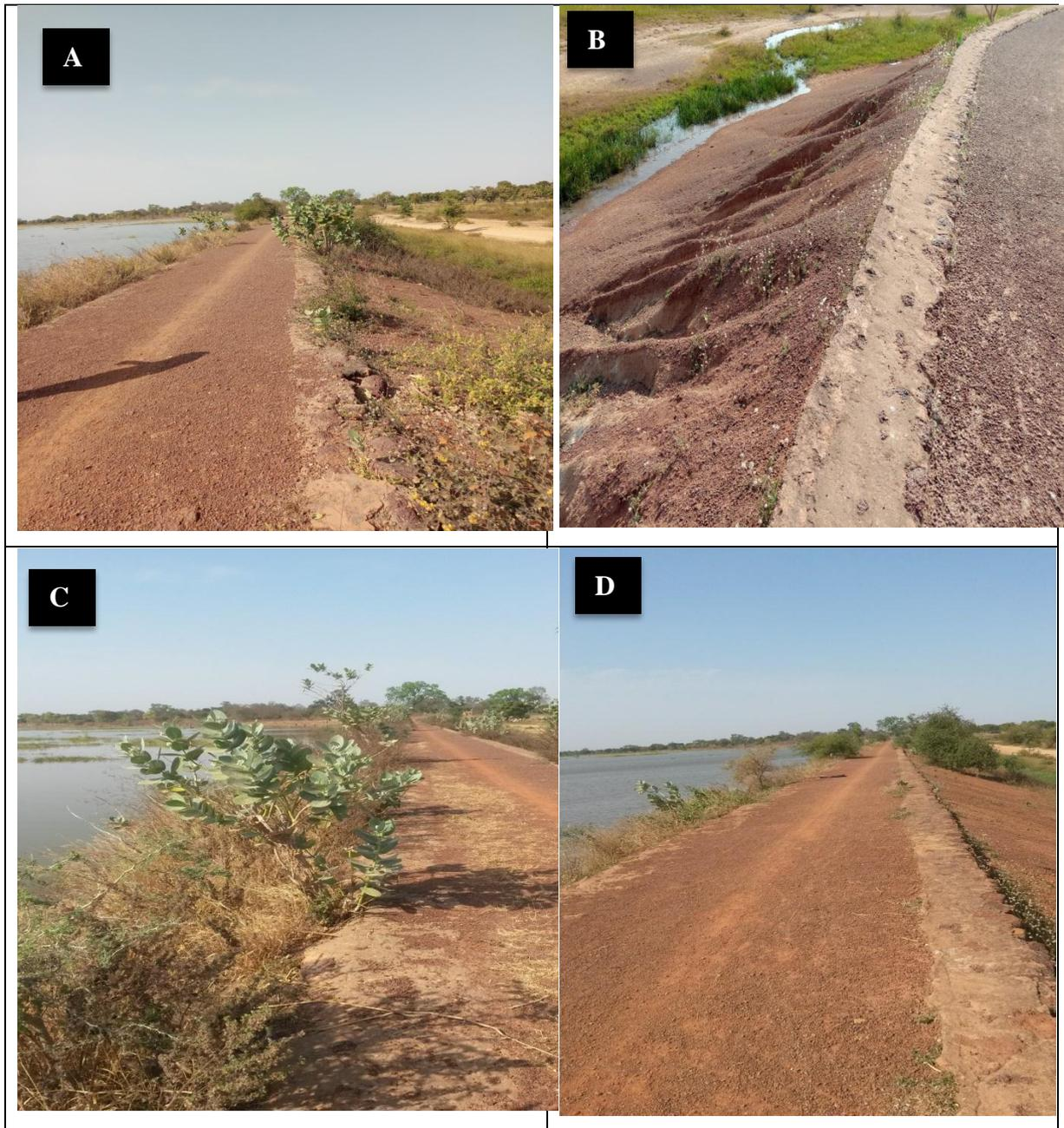
**Figure 3: Les anomalies identifiées sur digue du Barrage de HOUNDE**
