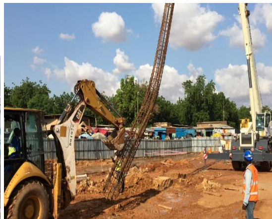
Figure 18 ; Mise de la cage d'armature
