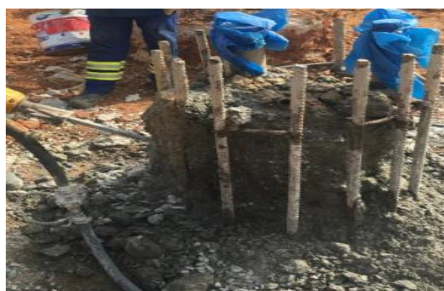
Figure 20 : Figure 19Recépage de pieu
