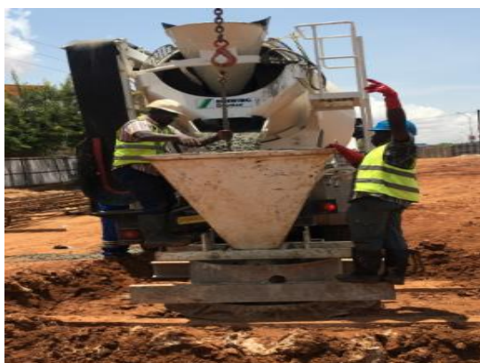
Figure 19 : Bétonnage du pieu
