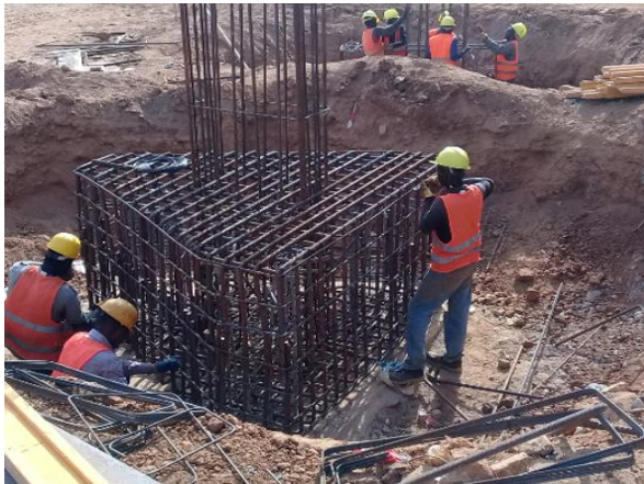
Figure 22 : Pose du ferrailage de la semelle
