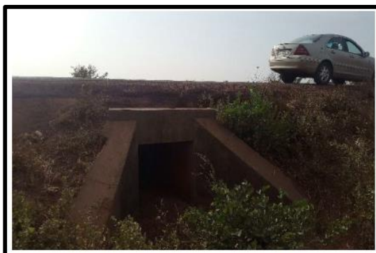
Figure 18 : Quelques images des dalots rencontrés sur le tronçon [1]
