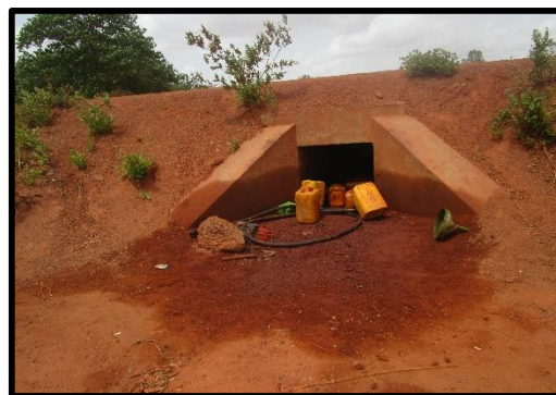
Figure 18 : Quelques images des dalots rencontrés sur le tronçon [1]
