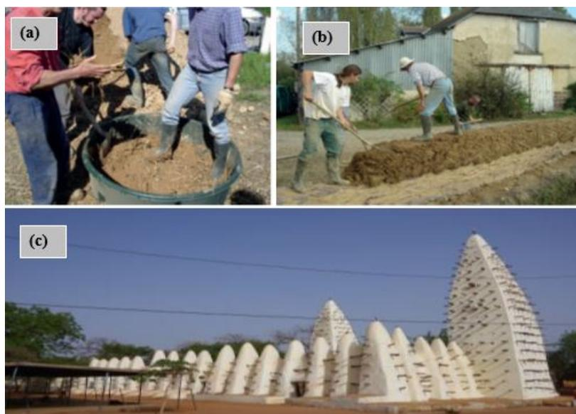
FIGURE 1.5 – Construction en Bauge; (a) :Mélange de terre crue et fibre végétales; (b) :Construction d'un mur en bauge; (c) : Mosquée en bauge à Bobo Dioulasso.
