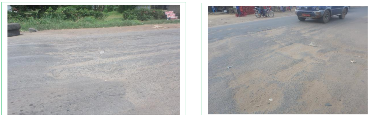
Figure 3: images illustrant des déformations
