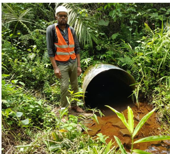
Photo 01 : Opération de diagnostic des ouvrages (buses métallique) sur le terrain
