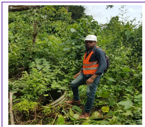
Figure 11 : Buse envasées et ensablée
