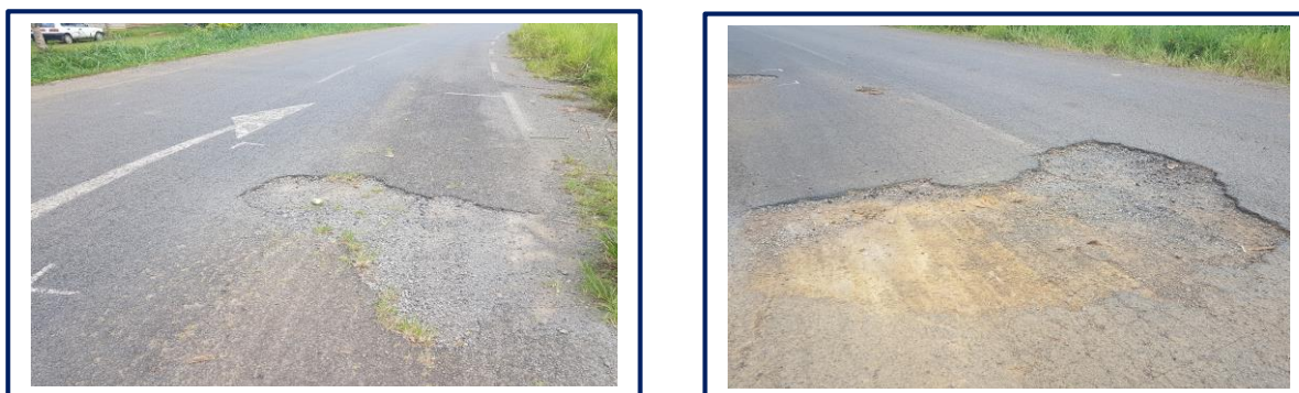
Figure 5 : illustration de l'arrachement du béton bitumineux
