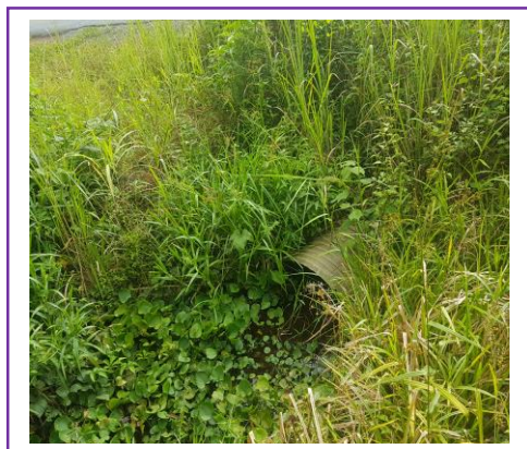
Figure 11 : Buse envasées et ensablée
