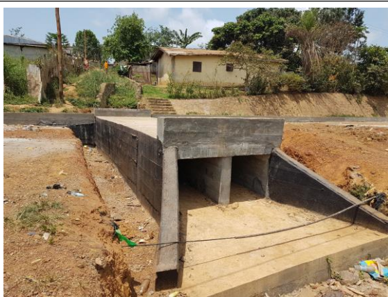
Photo 03 : Dalot de dimension 2x1x1 exécuté
