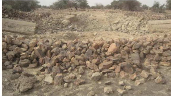
Figure 16 : Rupture de digue
