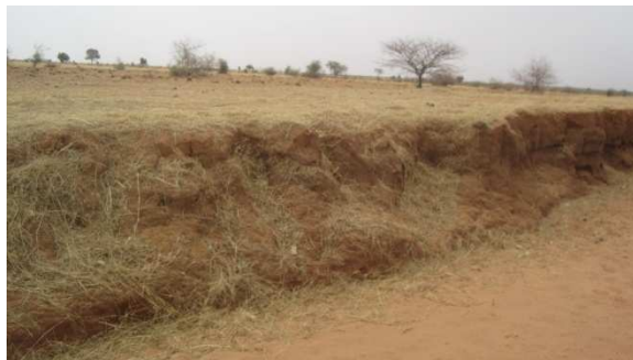
Figure 12 : Berges et fond sableux de kory
