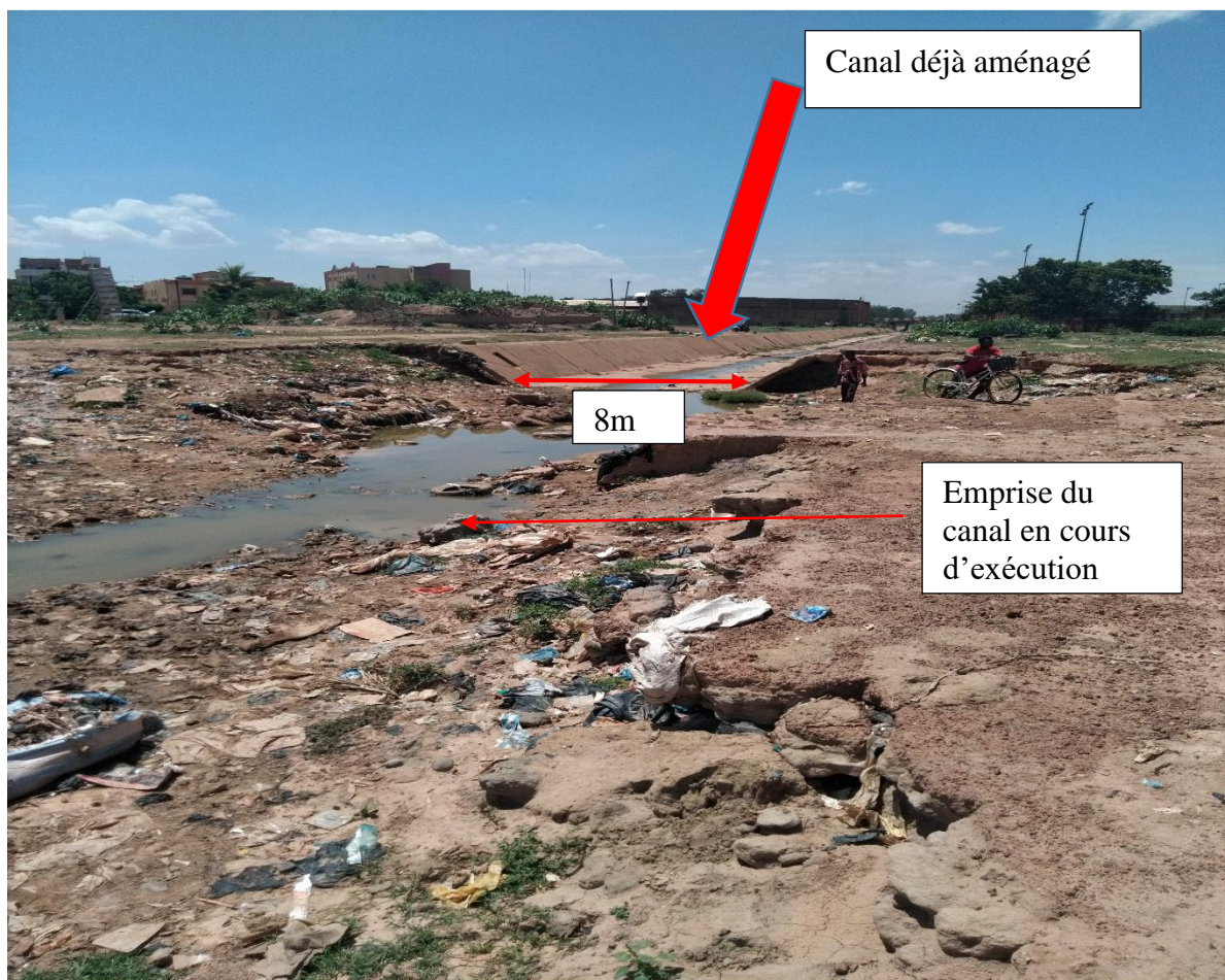
Figure 9: Ouvrage existant bétonné
