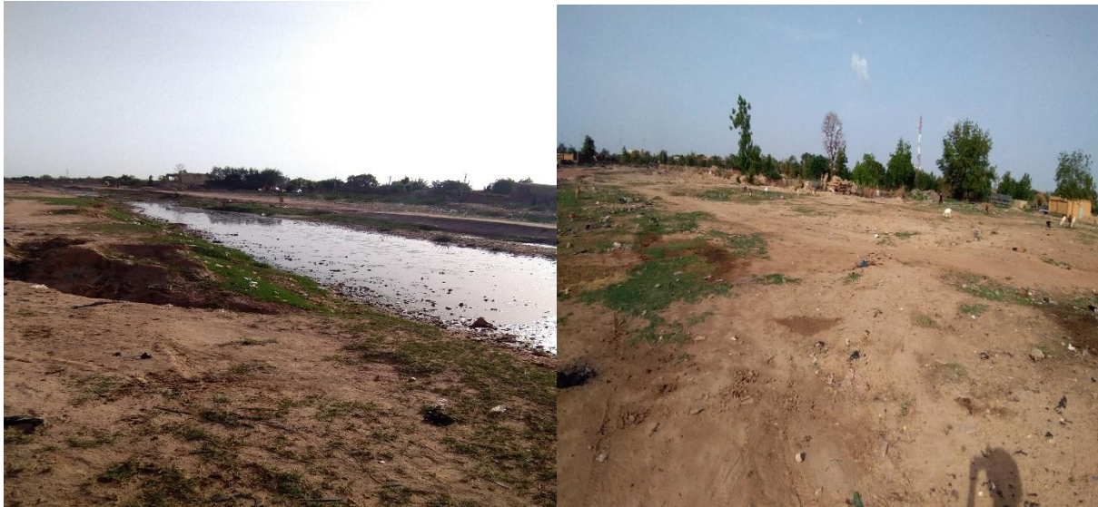
Photo 2: Emprise du canal du Mogho Naaba en réalisation Photo 3: Espace réservé à la réalisation du bassin de rétention
