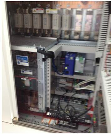
Figure 9 : Onduleur vue de l'intérieur
