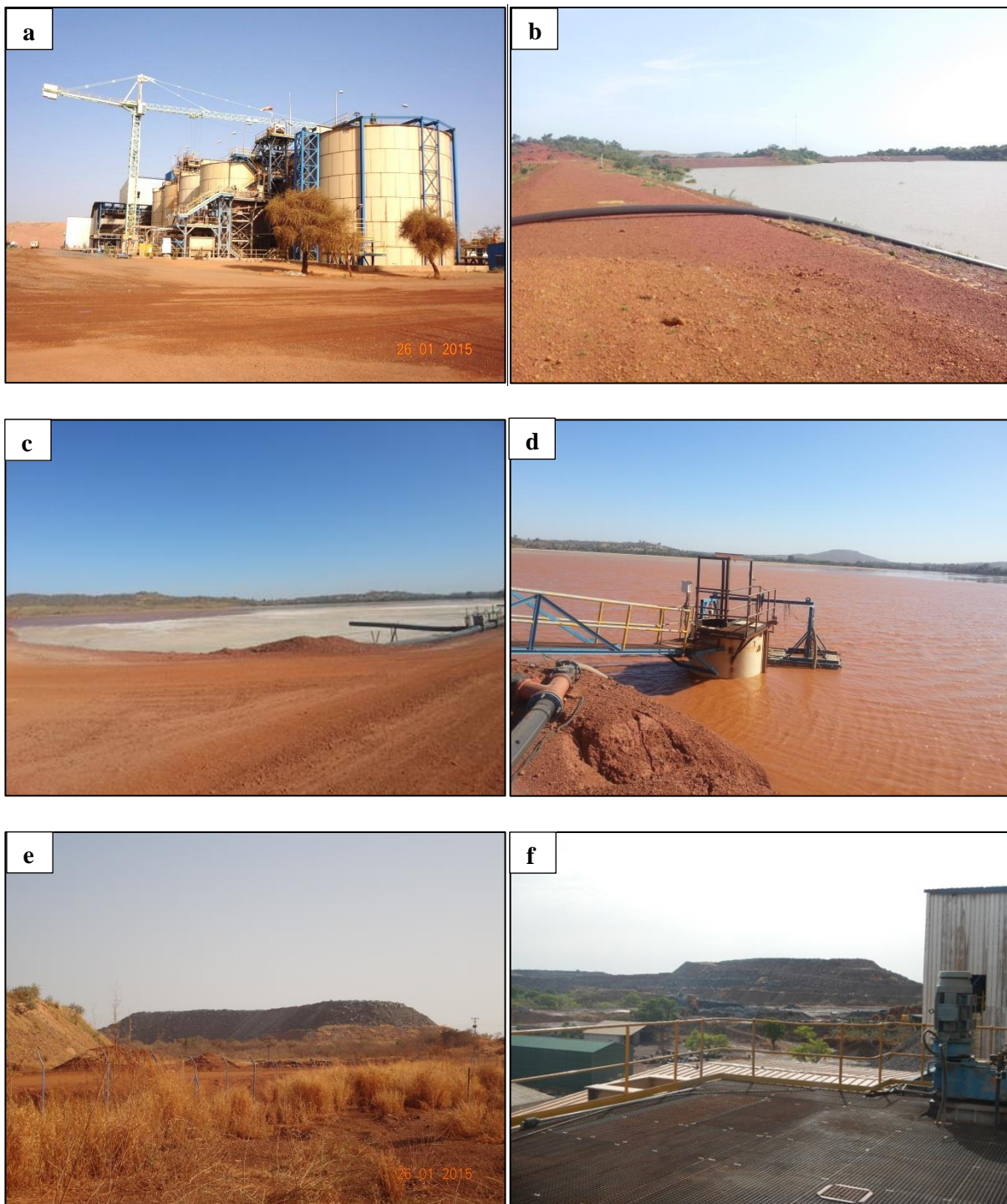
a : Photographie de l'usine de traitement, Mine Mana (Photo : A. TRAORE) b : Photographie du bassin Wona vu de la digue, Mine Mana (Photo : A. TRAORE) c : Photographie du parc à résidus : boues séchées, Mine Mana (Photo : A. TRAORE) d : Photographie du parc à résidus : barge flottante de pompage, Mine Mana (Photo : A. TRAORE) e : Photographie des haldes à stérile au sud-est de la fosse Kona, Mine Mana (Photo : A. TRAORE) f : Photographie des haldes à stériles au nord-est de la fosse Wona, vues du haut de l'usine de traitement, Mine Mana (Photo : A. TRAORE)
