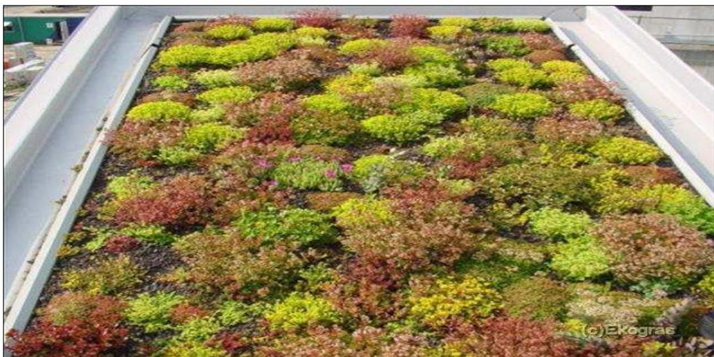
*Figure 7: toiture verte semi-intensive*
