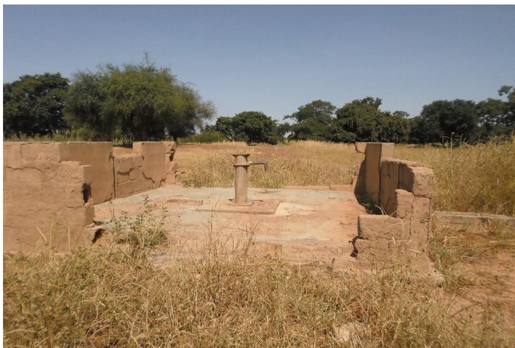
Figure 5: Forage abandonné dans le village de Lougou Mossi
