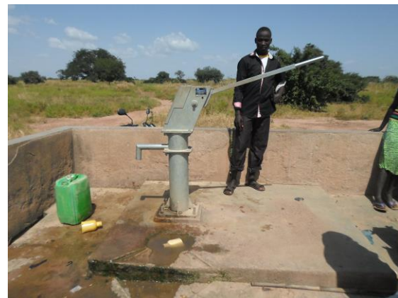
(D) Water ponding inside water point
