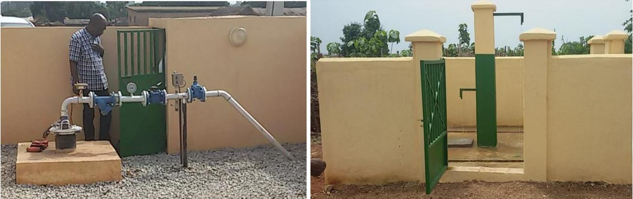
Les bornes fontaines sont équipées de deux becs de puisage : Une sortie basse pour le remplissage des récipients posés au sol (seau 10 l, 15 l en général) et une sortie haute pour le remplissage d'un récipient posé sur la tête (cuvette de 30 l). A la sortie des BF, un compteur enregistre le volume d'eau vendu
