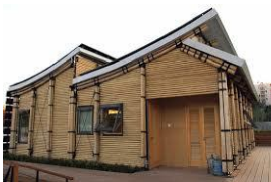
Le tronc des bambous utilisé dans la construction
