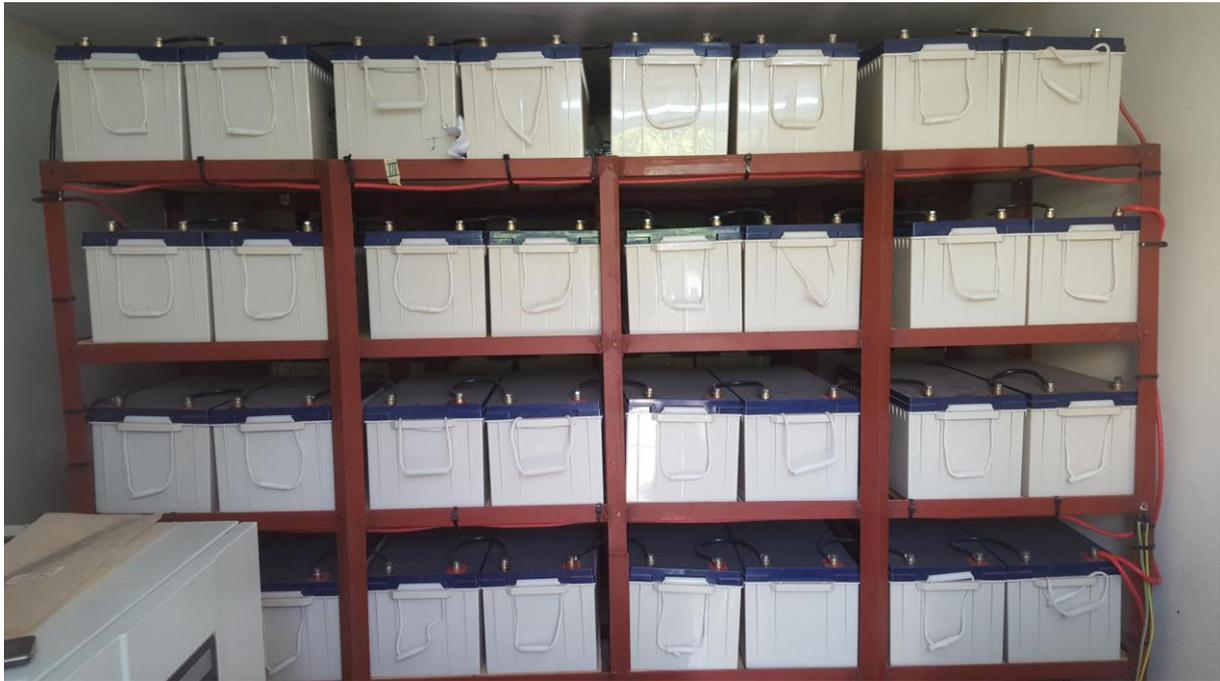
Photo 5 : Banc de batteries du sous-système III
