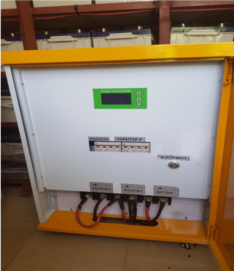
Photo 1 : Régulateur de charge 150 A/192 V des batteries d'un sous-système
