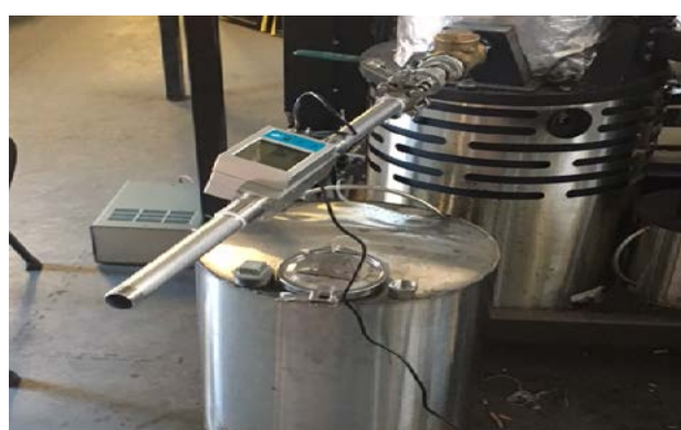
Débit mètre branché au GEK
