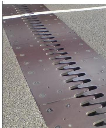
Figure 15: joint de chaussée de type cantilever
