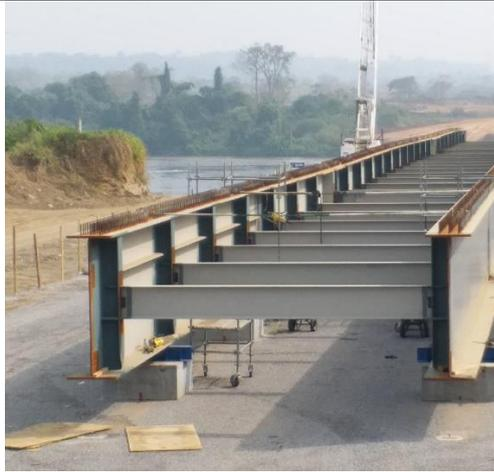
Photo 1: préparation de lançage de la charpente
