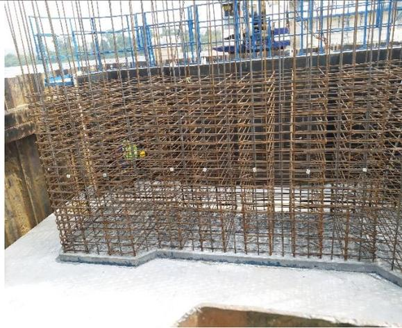
Photo 2: ferrailage de la pile
