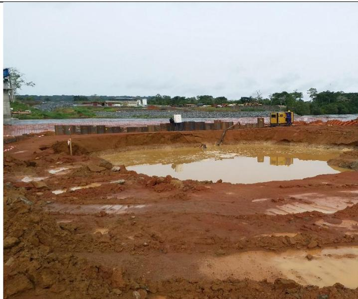
Photo 4: Excavation pour la réalisation de la pile P4
