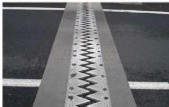
*Figure 13 : Illustration du joint de type "CIPEC Wd110"*
