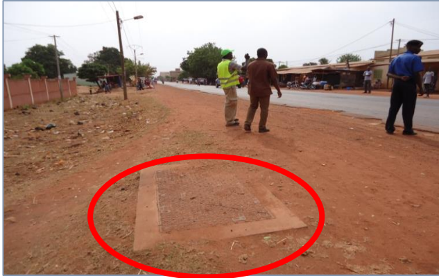
Photo 3 : PK 0+700 – Vue sur un regard téléphonique situé dans l'emprise Source : CIRA
