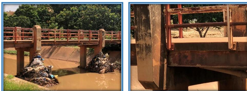
*Figure 13 : passerelle mixte acier-béton sur le campus de l'université de Ouagadougou. (Photo Adal Ouattara)*
