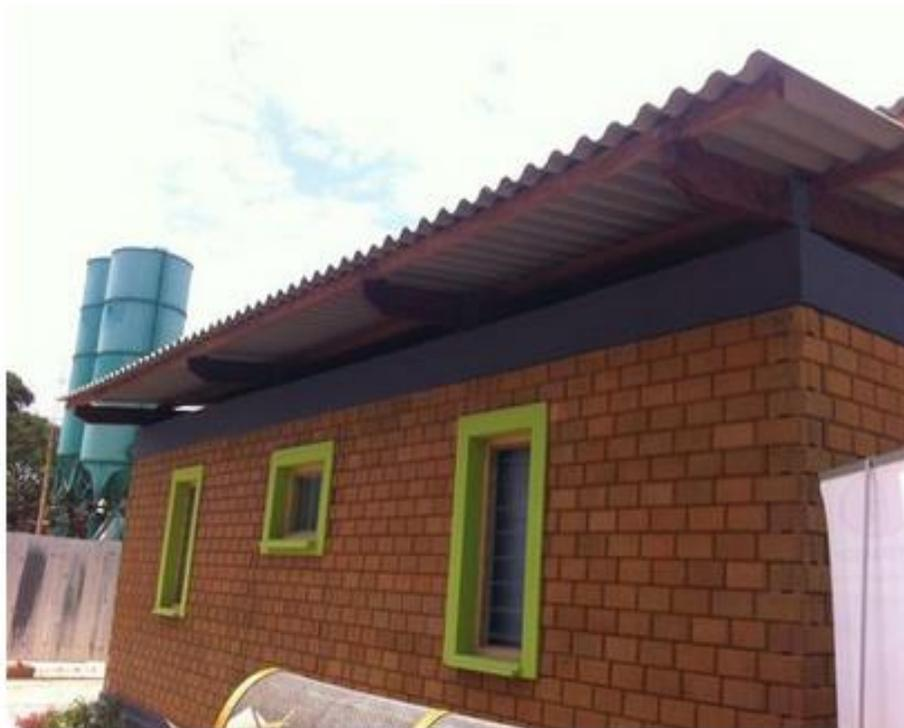
Figure 6: une construction à base de BTC
