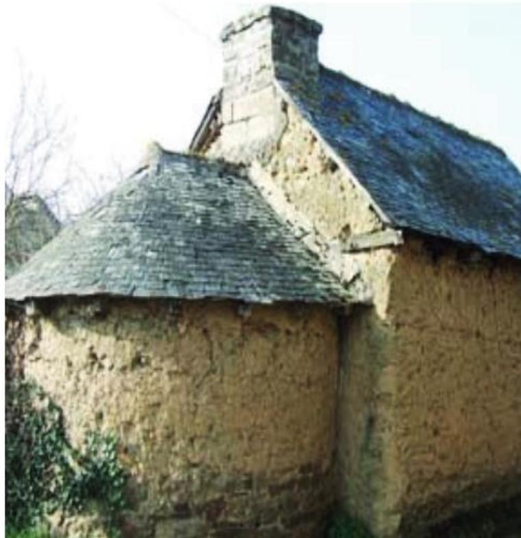
Figure 5: illustration d'une construction en bauge
