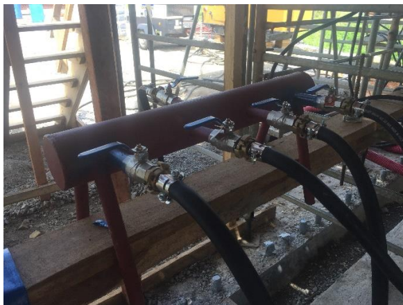
Figure 26 : clarinette et vannes d'air pour les coffrages-décoffrage.
