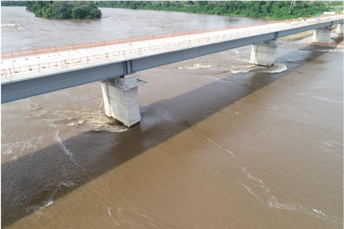
Figure 4 : exemple de pont bipoutre (en construction)
