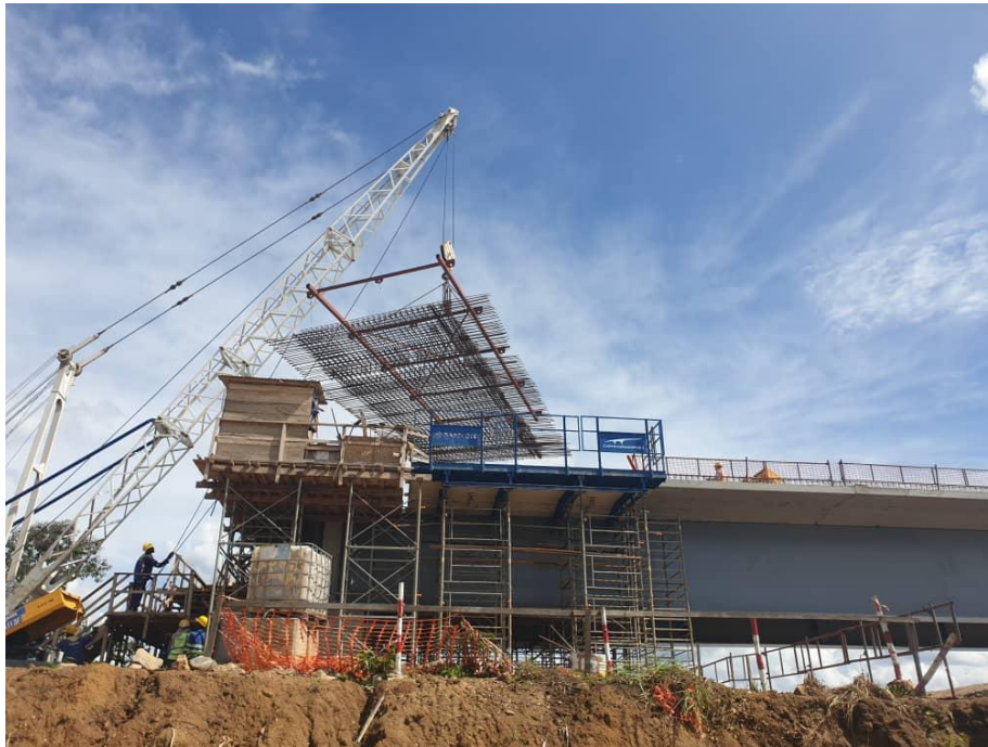
Figure 21 : mise en place des armatures
