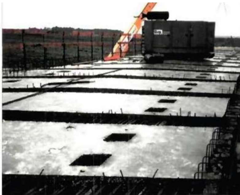
Figure 8: exemple de dalle de tablier préfabriqué [8]
