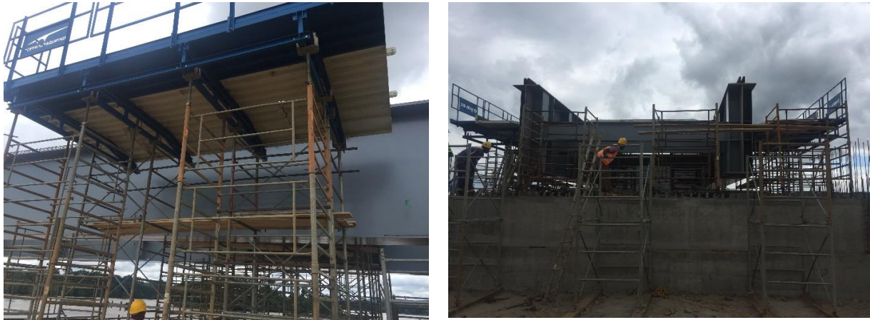
Figure 18 : étaillage et coffrage métallique de l'hourdis
