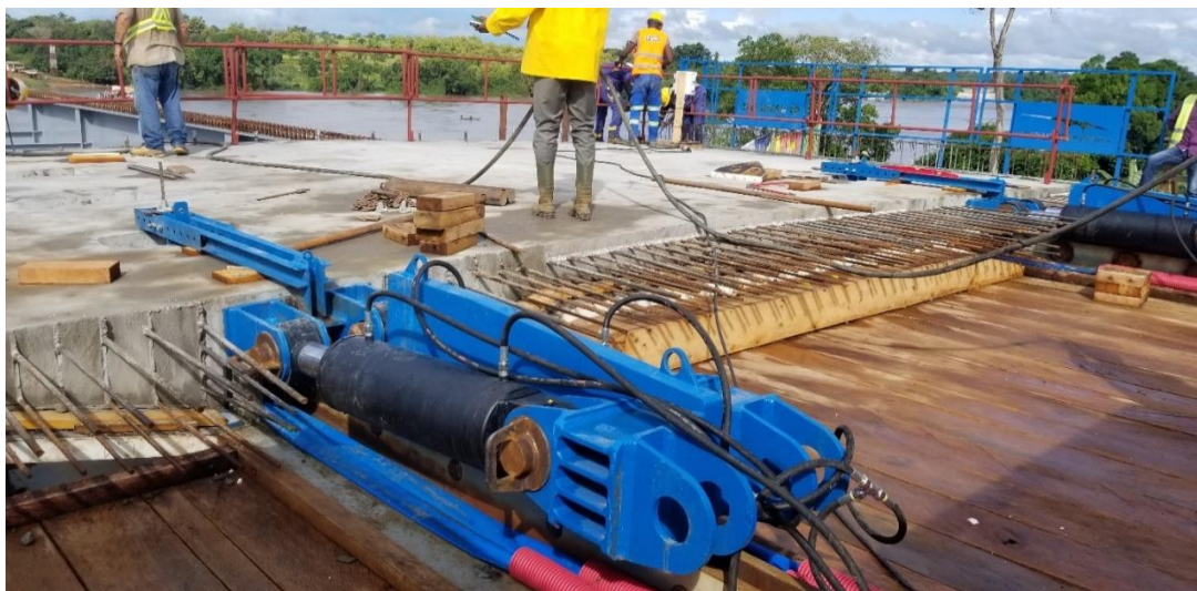
Figure 29 : vérin hydraulique du système de poussage.
