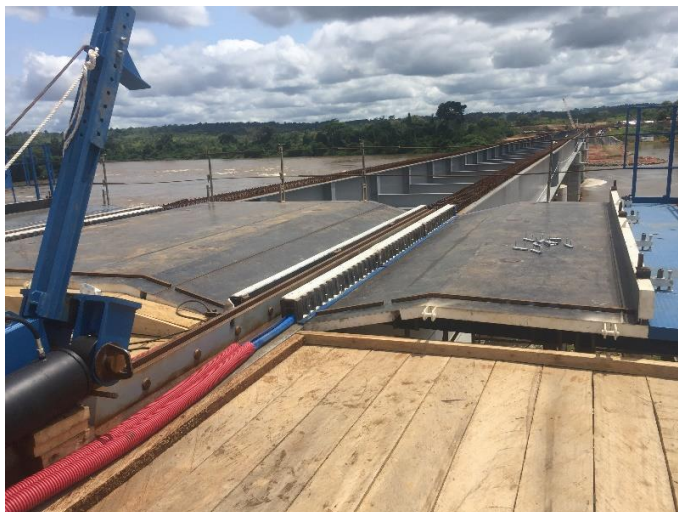
Figure 19 : partie supérieure du coffrage de la dalle
