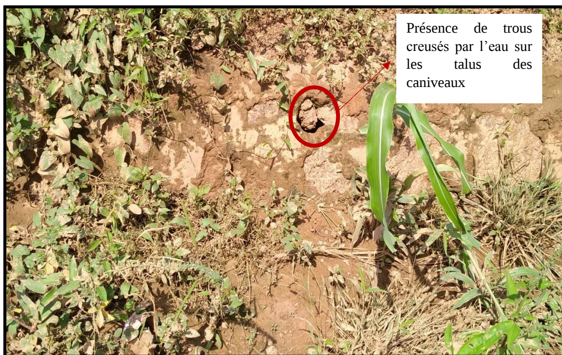
Figure 5: Végétation et terre dans les caniveaux existants sur le site de Kartenga
