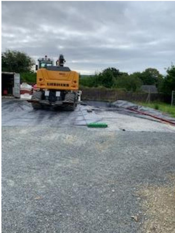
*Figure 4: Bassin de rétention d'eau polluée sur le chantier de Duault*
