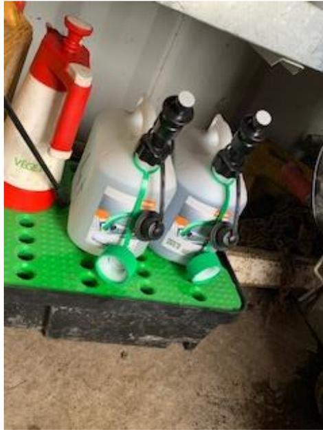
Figure 5: Bidons avec bec verseur anti-débordement stockés sur rétention
