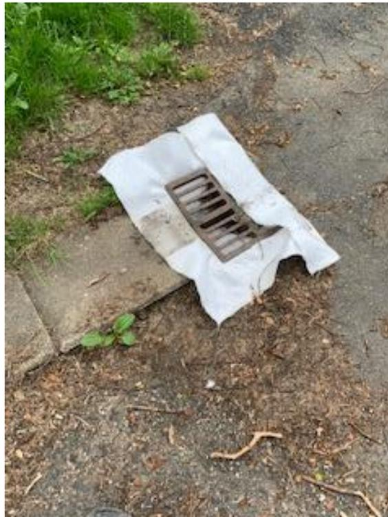
Figure 9: Protection des canalisations à grille au géotextile
