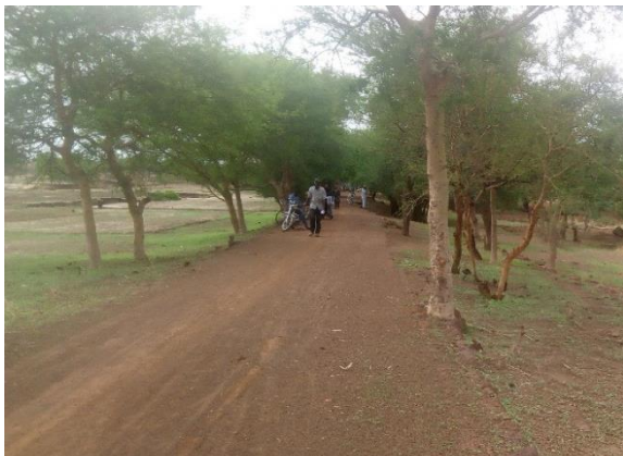
Photo 1 : Digue envahie par les arbres
