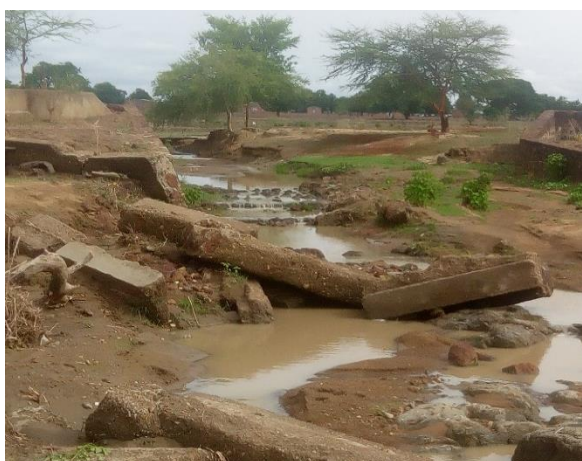
Photo 3 : Evacuateur de crue d truit
