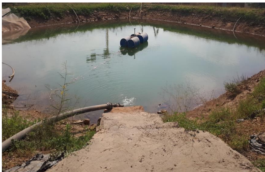
Image 1 : Bassin de rétention (RP 2 )
