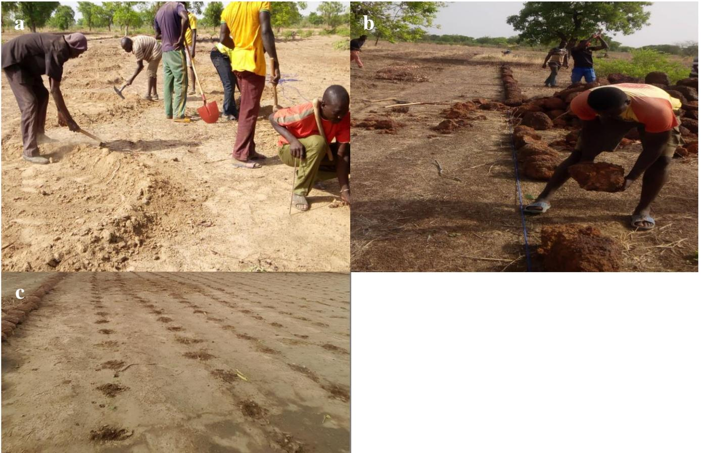
Figure 13: illustration de la réalisation des ouvrages CES a) Demi-lune b) Cordon-pierreux et c) Zai
