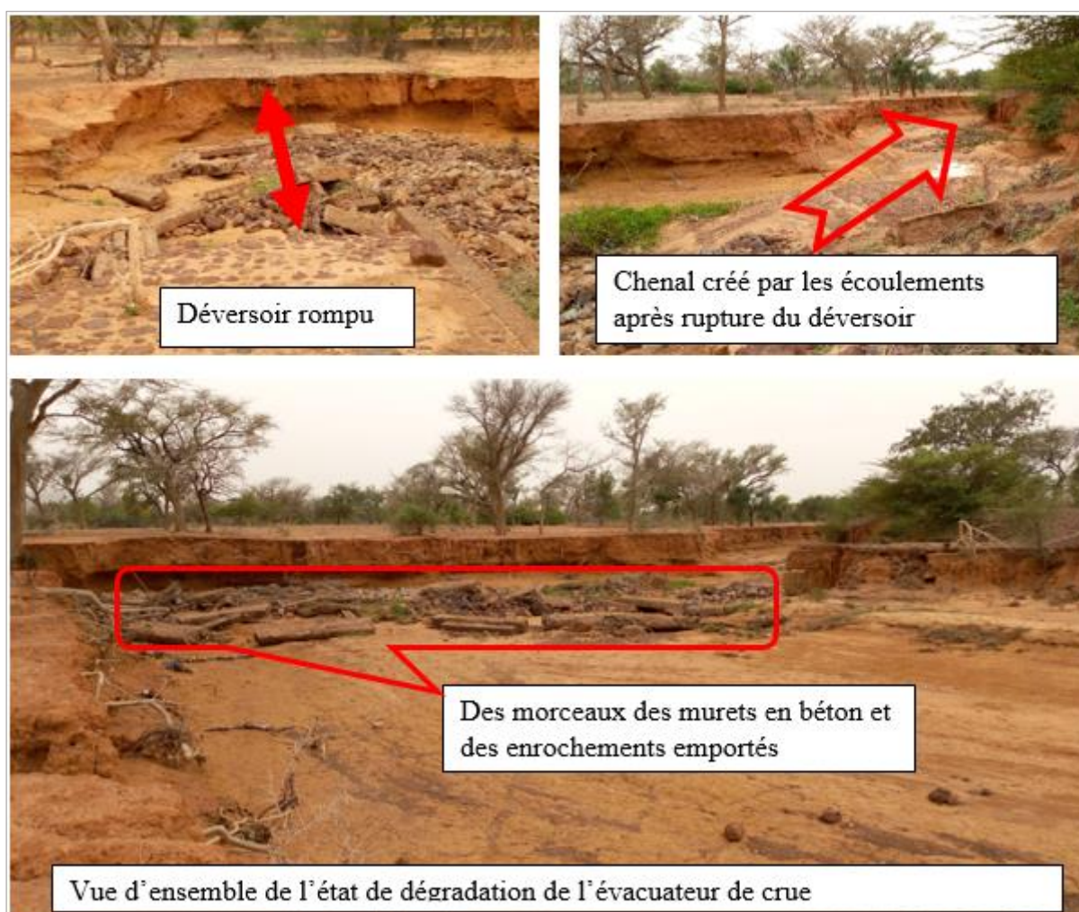
Figure 5: Planche illustrant l'état actuel de l'évacuateur de crue
