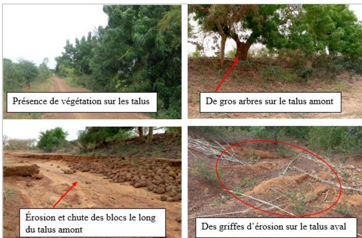
Figure 4: Planche illustrant quelques dégradations sur la digue
