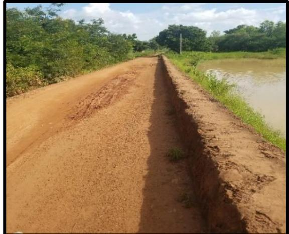
Figure 7: Crête de la digue affaissée
