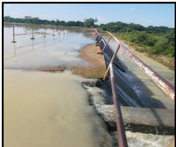
Figure 8: Fortes dégradations sur la crête de l'évacuateur de crue
