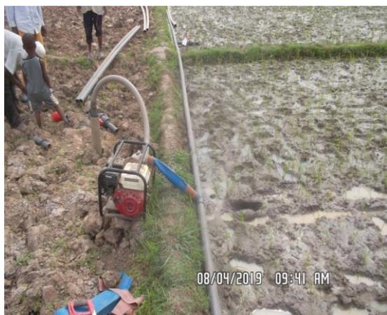
*Photo 11 : Installation des tuyaux d'irrigation*
