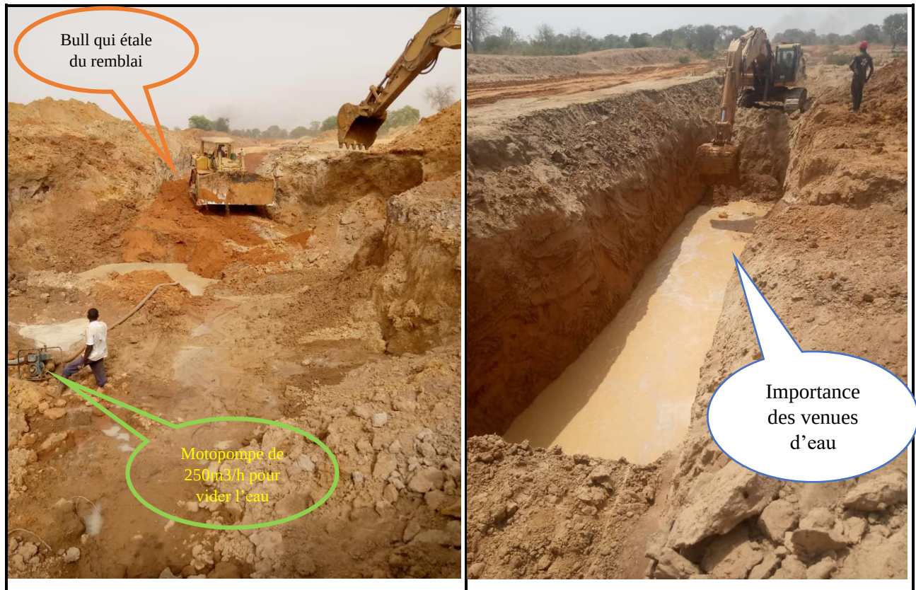
Image 6 : Illustration de l'exécution de la tranchée.
