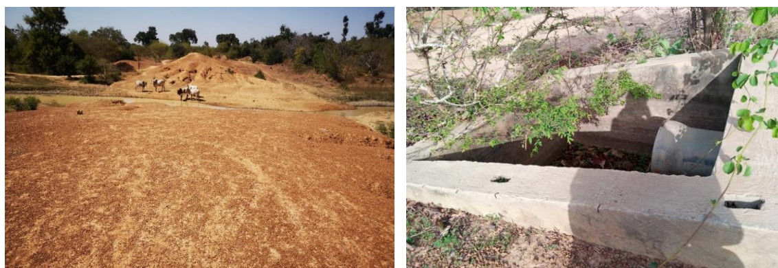
Figure 7 : Digue actuelle du barrage de TOEMIGHIN
