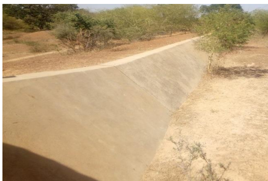
Figure 6: Déversoir actuel du barrage de TOEMIGHIN
