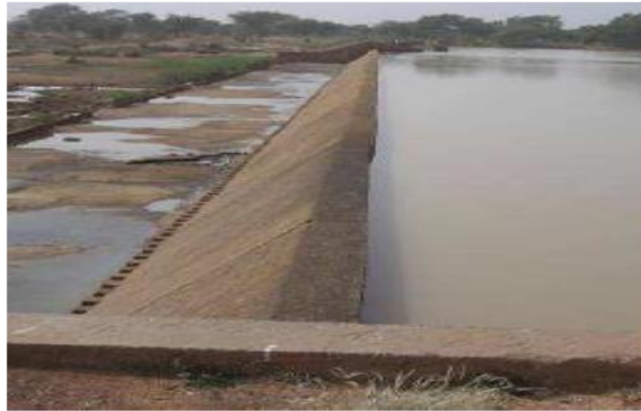
Figure 1: Déversoir trapézoïdal du barrage de Korsimoro
