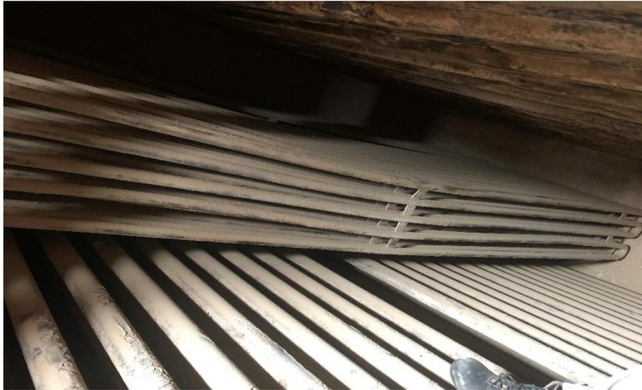
**Image 3 : Illustration des dépôts de suie et de tartre**
