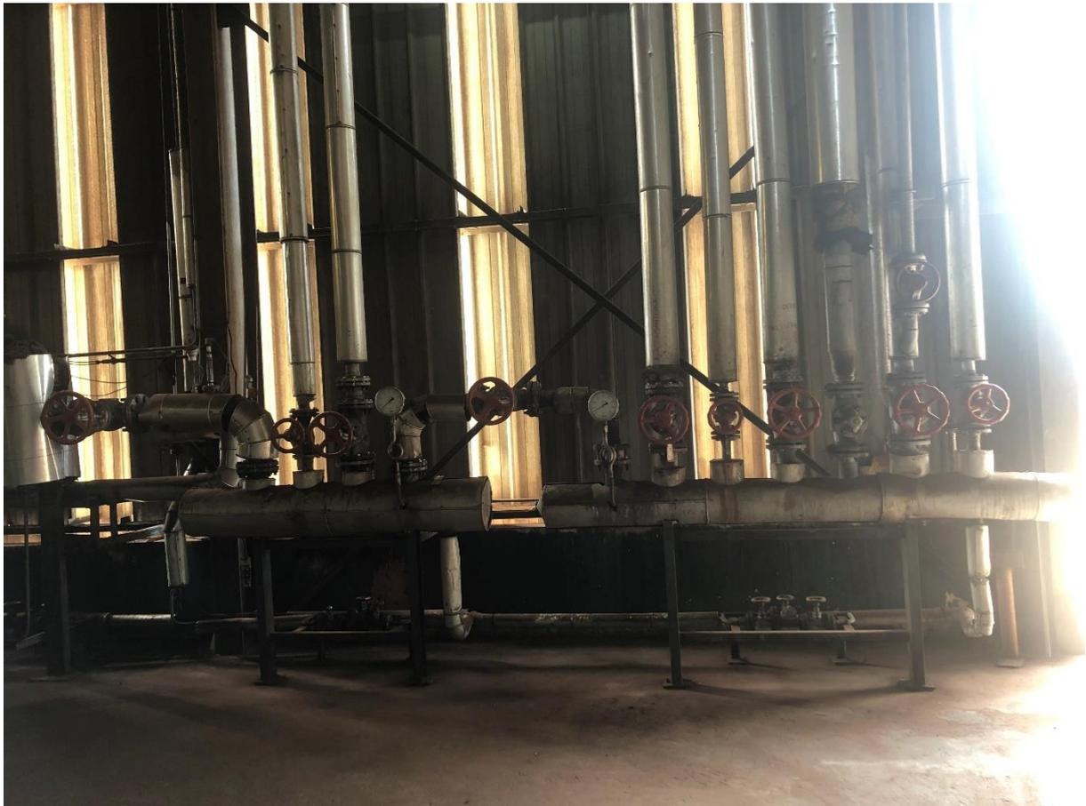
**Figure 5 : Barillet de dérivation du circuit vapeur**
