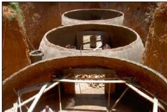
**Figure 4 :** Digesteurs 100 m<sup>3</sup> en série – Prison Rwanda (Mottet, 2019)
