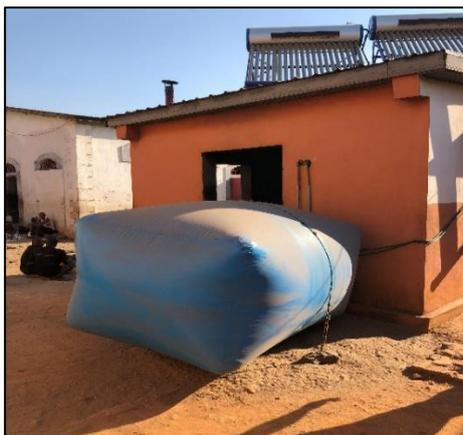
**Figure 10:** Bâche de stockage de méthane de capacité de 2 m<sup>3</sup> (Source : J.Jousselin, CICR, 2018)
