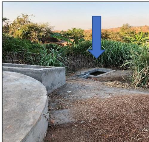
**Figure 11:** Filtre à sable installé pour un post traitement naturel du digestat (Source : J.Jousselin, CICR, 2018)
