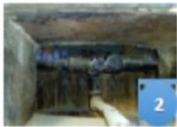
Si des bulles apparaissent, il y a une fuite. Fermer la vanne de sécurité et contacter le technicien biogaz
