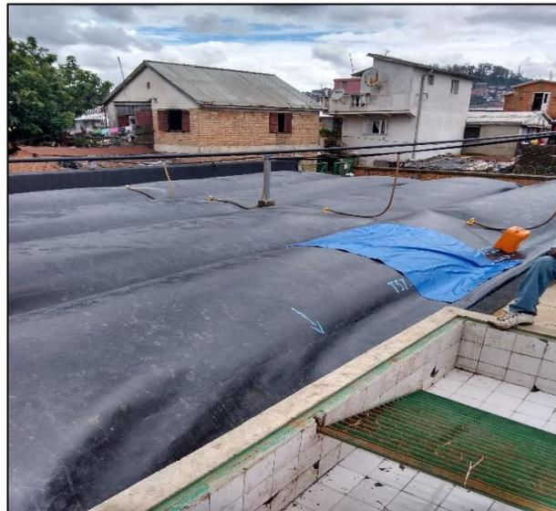
**Figure 3 :** Biodigesteur non maçonné flexible de 160 m<sup>3</sup> à la station de traitement des boues de latrines dans le « bas quartier » défavorisé de Antananarivo, WSUP & CARE (Source : J.Jousselin, CICR, 2018)
