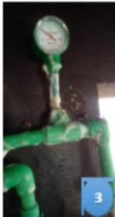
Si la pression du biogaz est anormalement faible : pression en dessous de 6 KPa (1) ou flamme faible (2), il faut vérifier la présence potentielle de fuite sur certains endroits critiques de l'installation, au niveau des vannes et de la tuyauterie (raccords, coudes, T), à l'aide de l'eau savonneuse (3).
