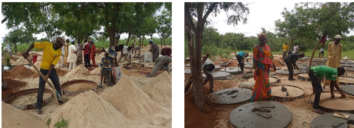
Figure 12: Confection des dalles Sanplat améliorées
