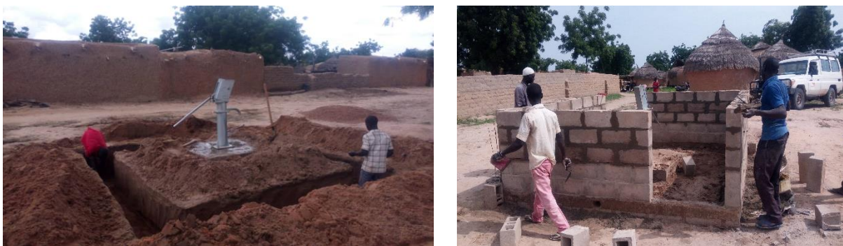
Figure 6: Réalisation d'une superstructure
