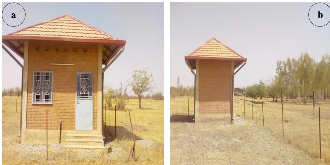
Figure 2.2 : Bâtiment pilote a) façade Sud b) façade Ouest
