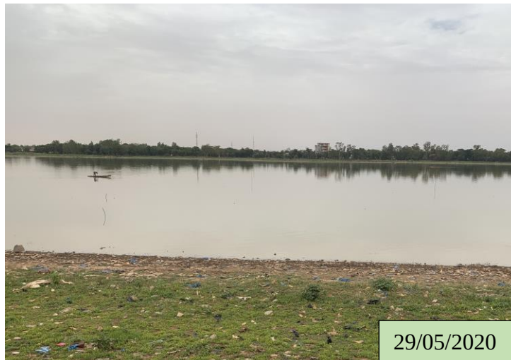
Photo 4 : Vue du barrage n°2.
