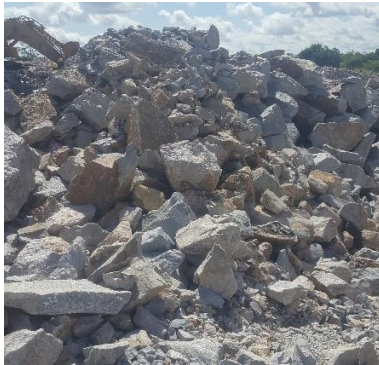
Abattage de la roche
