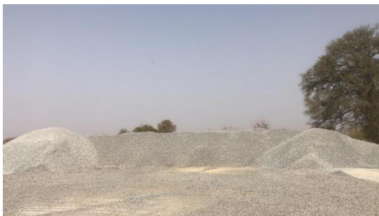
Stockage des granulés
