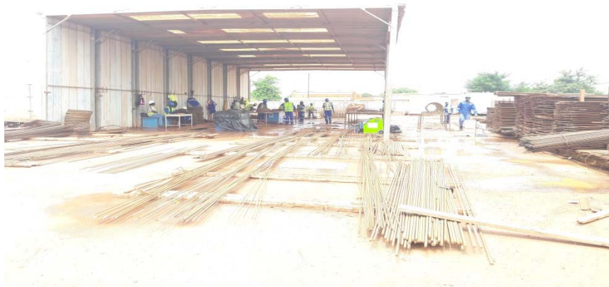
Figure 11 : Atelier de ferrailage
