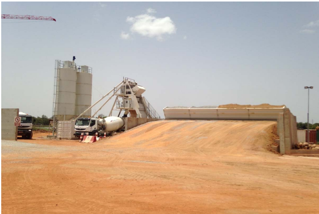
Figure 6 : Centrale à béton installée à la préfabrication
