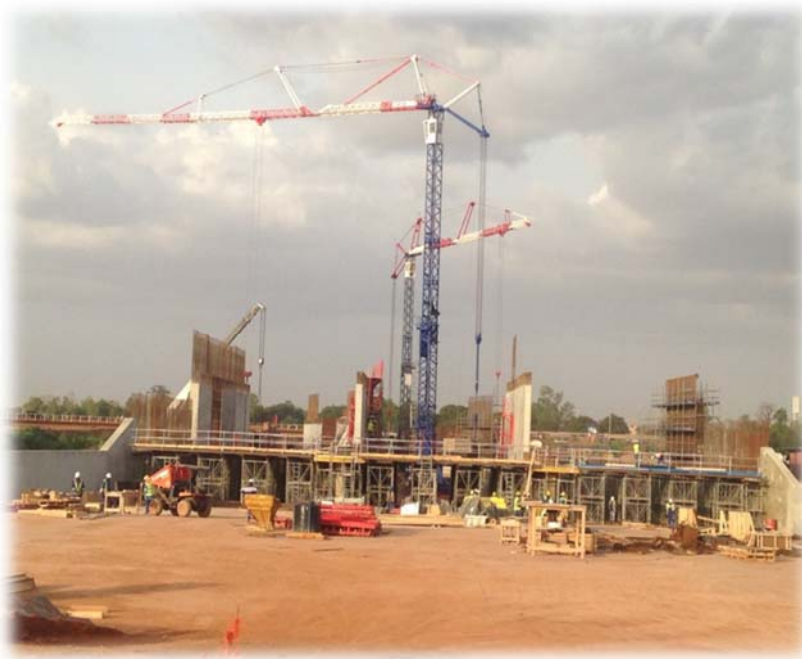
Figure 2 : Grue à tour
