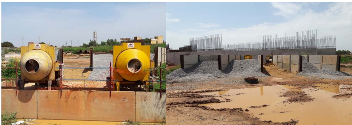
Figure n° 9 : Poste de bétonnage à la bétonnière
