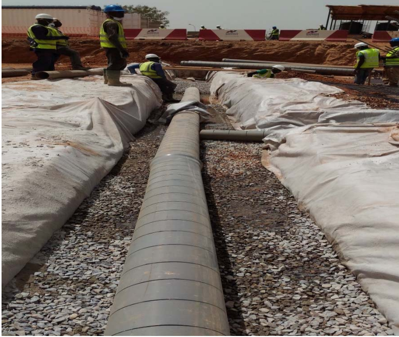
Figure 13 : Pose des drains
