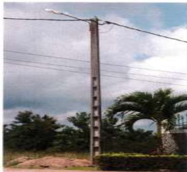
Figure 13 : Poteau en béton armé
