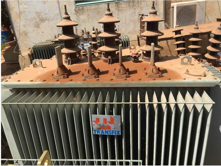
Figure 1: transformateur de distribution a borne embrochable
