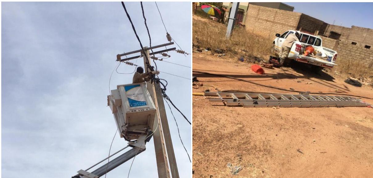
FIGURE 30 : Illustration des travaux de maintenance à la SONABEL
