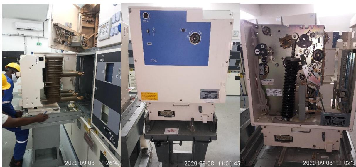
**Figure 32: Disjoncteur HTA à gaz SF6 associé à son relais de protection du poste source de Bellevue**
