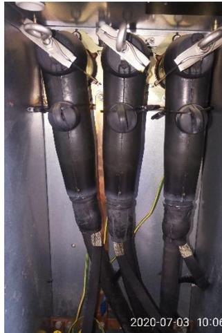
Figure 47: Tête de câble d'une cellule HTA avant montage du tore
