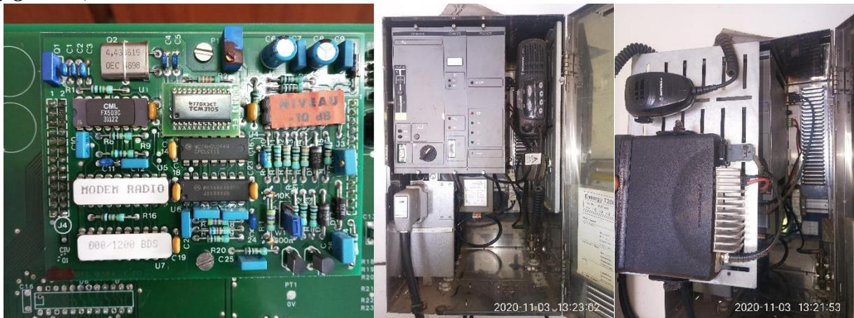
Figure 64: Equipement de télétransmission des OMT des postes télécommandés
