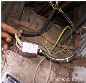
Figure 49: Faisceau pour tore MF1
