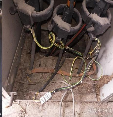
Figure 48: Montage du tore sur les têtes de câble de la cellule HTA
