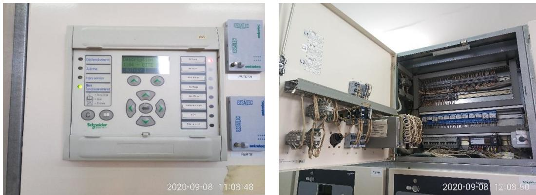
Figure 25: Relais de protection de type P142
