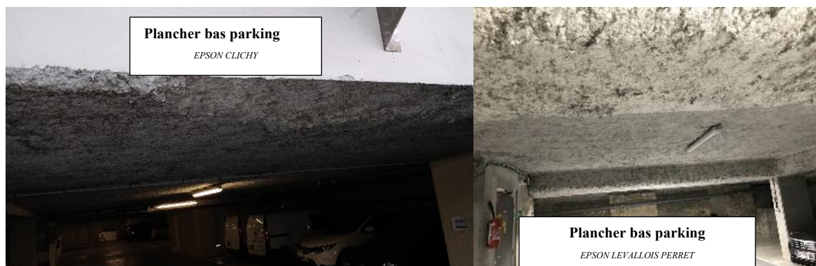
Figure 4: Vues des planchers bas des différents bâtiments
